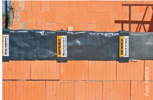
Bild 9: Schutz des Mauerwerks im Bauzustand
