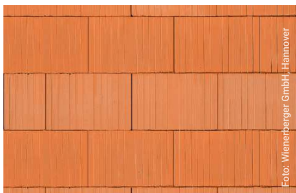
Bild 7: Normgerechtes Überbindemaß
