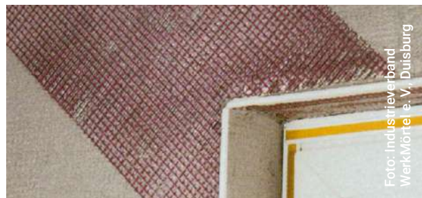
Bild 6: Armierungspfeil an Öffnungsecken
