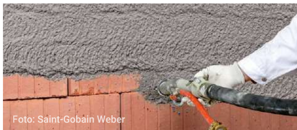
Bild 11: Auftrag des Unterputzes auf Planziegelmauerwerk
